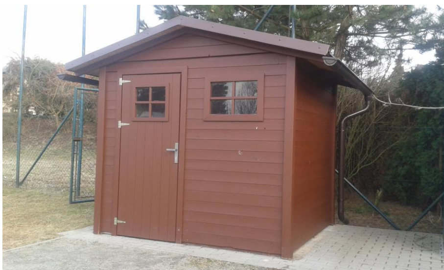
Opravený domek na náradí
